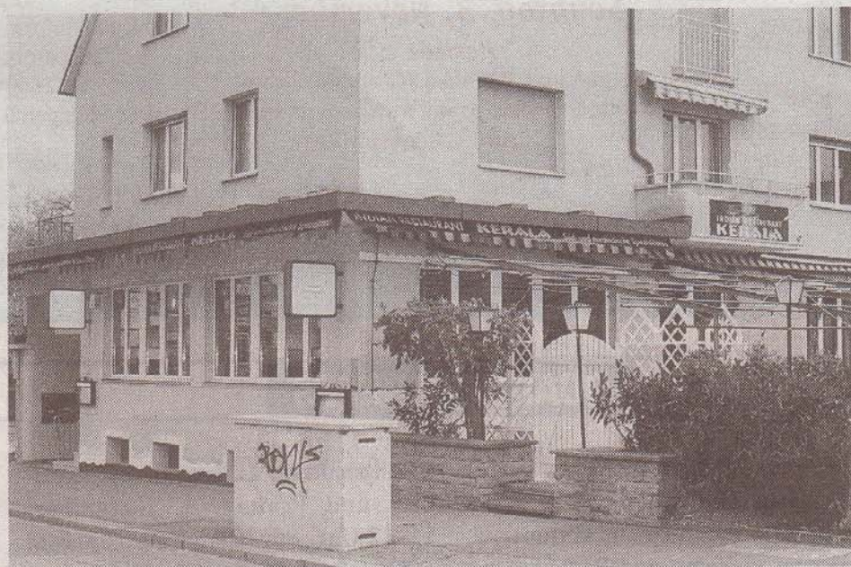
Die Fassade des «Kerala» wurde neu gestrichen.
